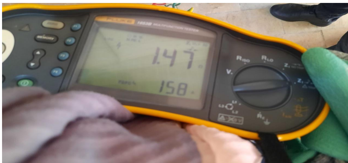
اندازه گیری امپدانس حلقه خارجی در ورودی کلید MCCB کنتور امپدانس حلقه خارجی Ze با دستگاه مالتی فانگشن فلوگ 1653 B
